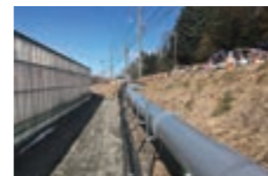
富士見工場の排温水やボイラー排ガス中のCO 2 を、隣接する菜園のトマト栽培に利用しています。
