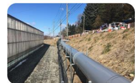
工場の排CO2を菜園に送る配管
