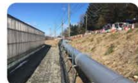
工場の排CO2を菜園に送る配管
